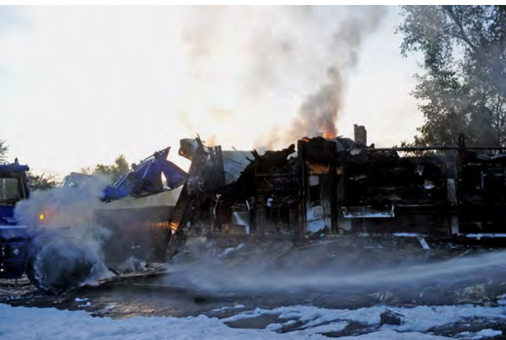
Der THW Radlager öffnet die Brandnester zum ablöschen
