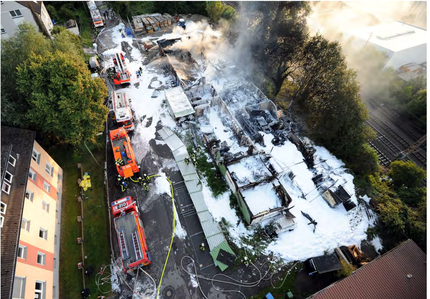
Die Einsatzstelle von einer DLK. Aufräum- und Nachlöscharbeiten stehen noch an. (1)
