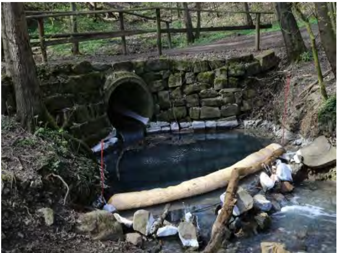
Folge der starken Ätzwirkung des Wassers. Kanal und Steine weisen starke Ätzwunden auf
