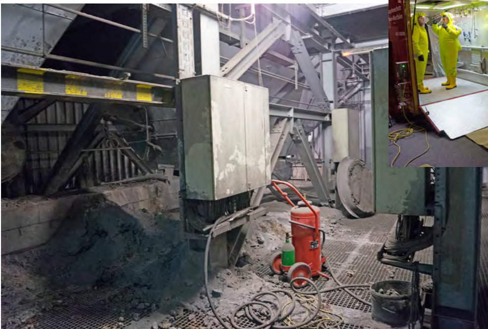
Oben: „Mannloch“ der Filteranlage vorbereiten der „Dekon-Anlage“ Links: Große Mengen an Filterasche wurde aus der Anlage entfernt und abgelöscht
