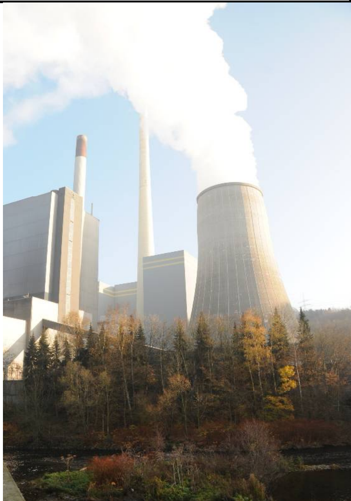
Mark-E Kohlekraftwerk in Werdohl Elverlingsen
