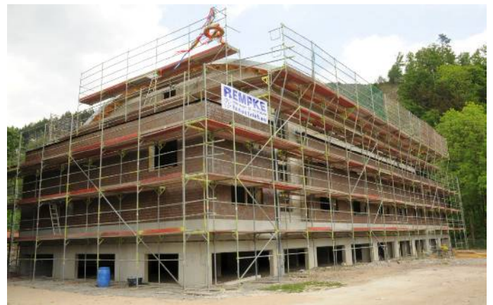
GH Dahl, Rückseite. Gut zu sehen ist die untere offene Bauweise wg. Überflutungsbereich der „Volme“
