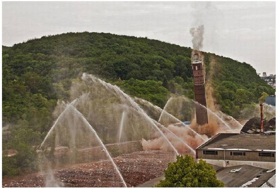
Der fallende Schornstein mit einem letzten „Rauchzeichen“ und den Wasserwerfern (2)
