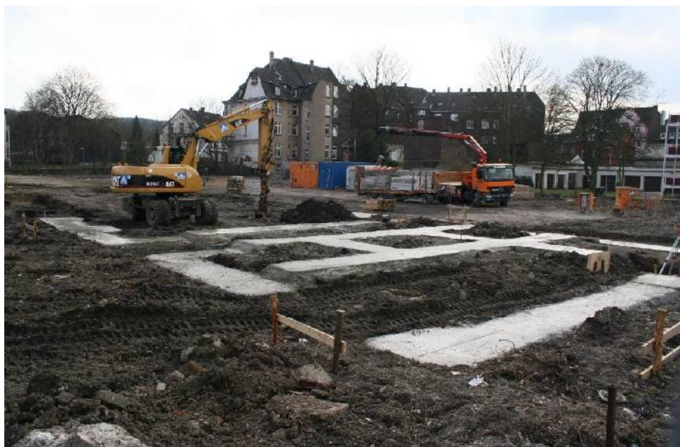
Die Bagger rollen in Vorhalle an
